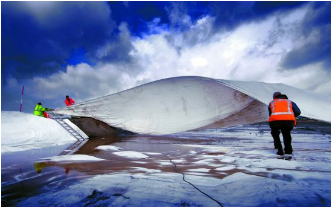
Om wegzakken van de A2 te voorkomen, plaatst men een in geotextiel verpakt zandbed, na eerst de grond met drainagestroken te hebben gestabiliseerd (beeld: Ton Borsboom)
