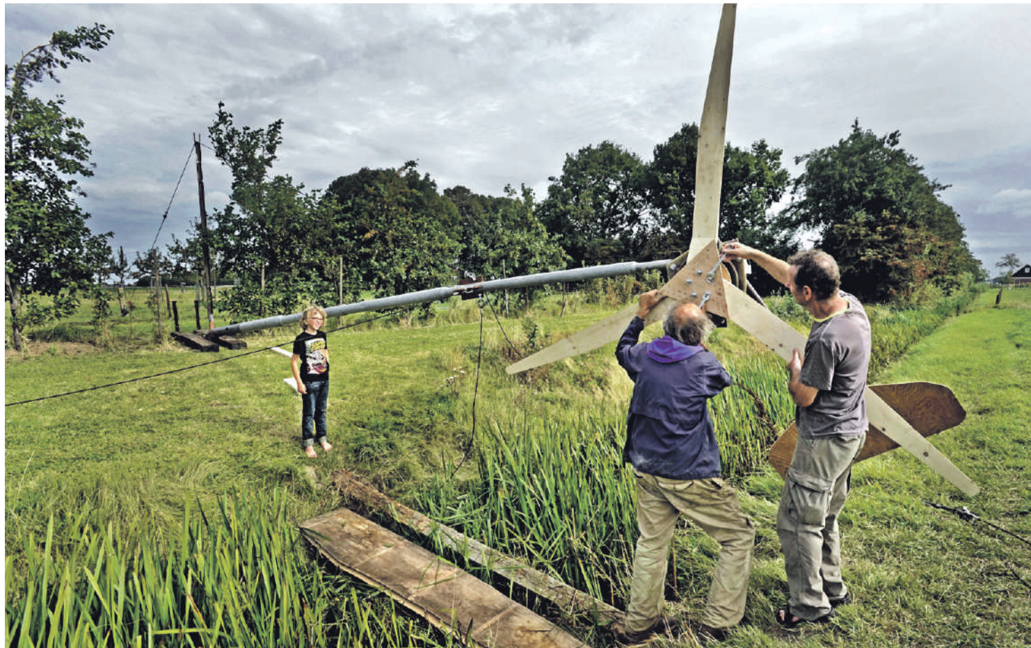
Een zelfbouw windmolen wordt geïnstalleerd op een boerderij in Wogmeer.
