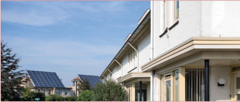
Gebouwkwaliteit: zonne-energie op woningen in de wijk Nieuwland in gemeente Amersfoort.
